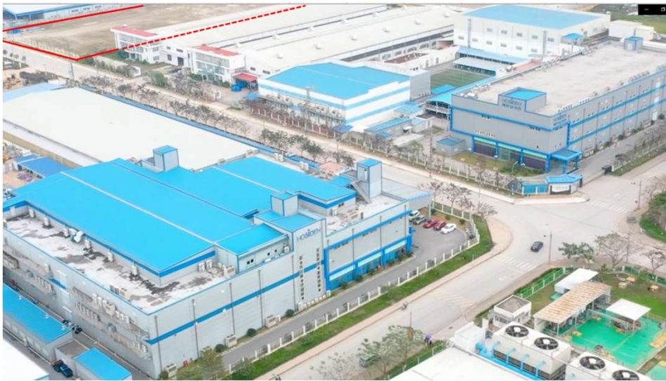
ホシデンベトナム(バクザン) (赤枠が8号棟建設地)
